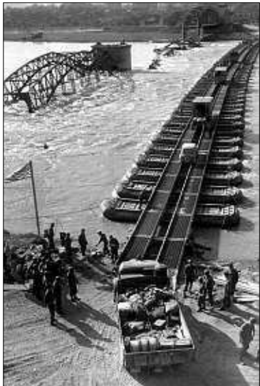
Die Notbrücke aus Pontons.
