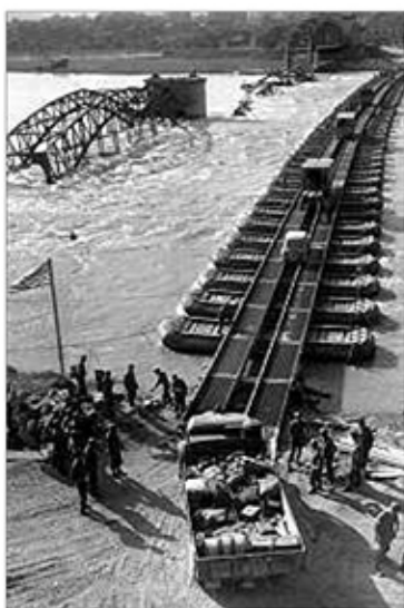
Die Notbrücke aus Pontons.
